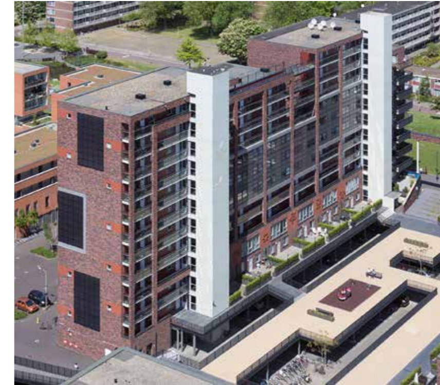
Verbouwde Poptahof. © Ossip/Molenaar & Co architecten
